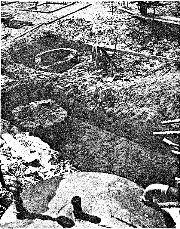
Byggegruben med 3 af de gamle brønde. Det drejer sig her om murede brønde, der tydeligt ses i grundens sandlag.
